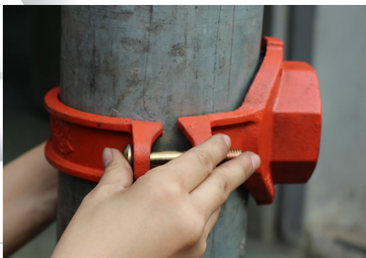
③鞍座裝上輕微搖晃緊貼 管材並旋上螺栓及螺帽
